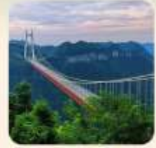
สะพานอ้ายจ้าย
